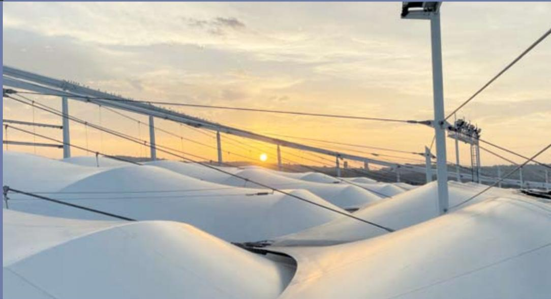
Die neue, hochtransluzente Dachmembran lässt viel Licht ins Stadion, so dass weniger künstliches Licht zugeschaltet werden muss.
