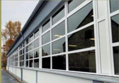
Die neuen Kunststofffenster und die Fassadendämmung verbessern die energetische Bilanz der Halle.
